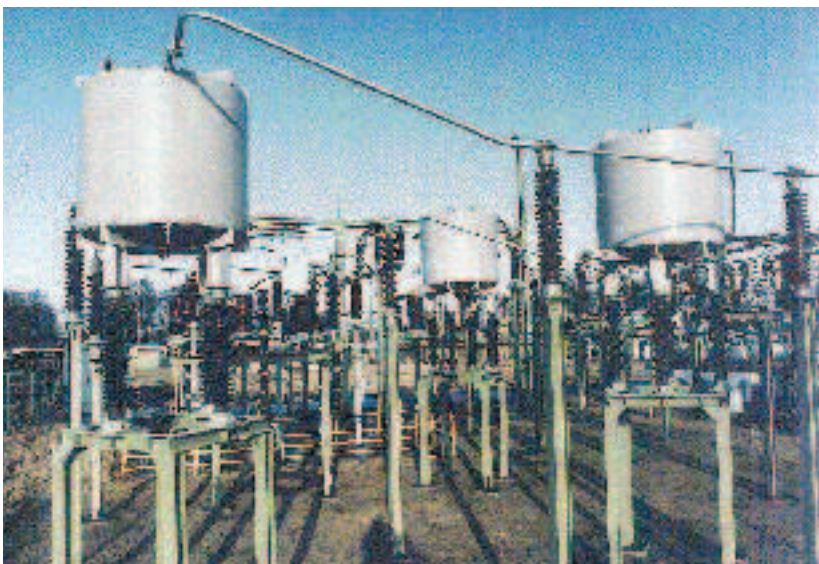
Рис.3. Однофазные реакторы последовательного включения
