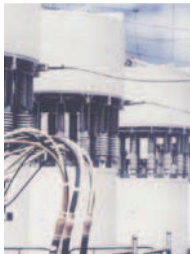
Рис.12. Шунтирующий реактор, подсоединенный через третичную обмотку трансформатора
