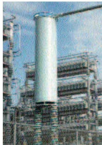
Рис.4. Токоограничивающий реактор
