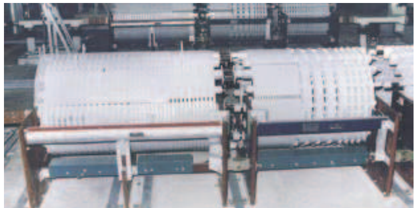
Рис.24. Регулируемый токоограничивающий реактор
