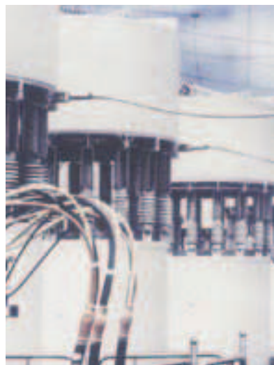
Рис.12. Шунтирующий реактор, подсоединенный через третичную обмотку трансформатора
