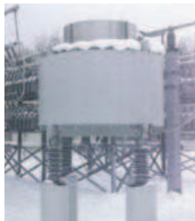
Рис.9. Фильтровые реакторы с регулирующими кольцами
