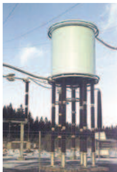
Рис.17. Высоковольтный сглаживающий реактор для линии постоянного тока
