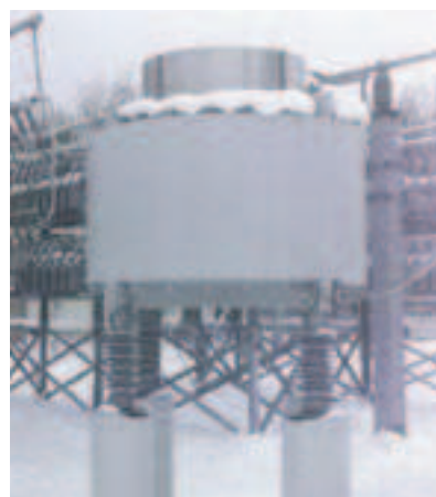
Рис.9. Фильтровые реакторы с регулирующими кольцами
