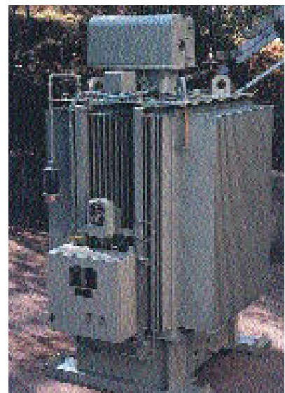
Рис.28. Стандартный дугогасящий реактор
