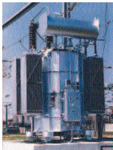
Рис.27. Дугогасящий реактор на 110 кВ
