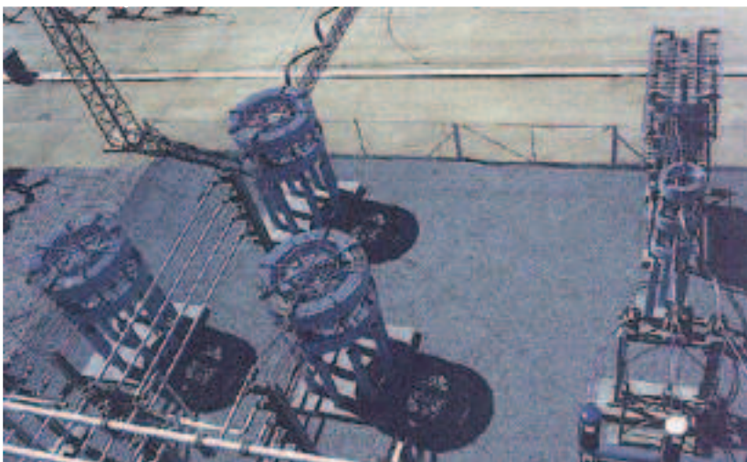
Рис.13. Шунтирующие реакторы с тиристорным управлением и фильтровые реакторы в схеме компенсации реактивной мощности
