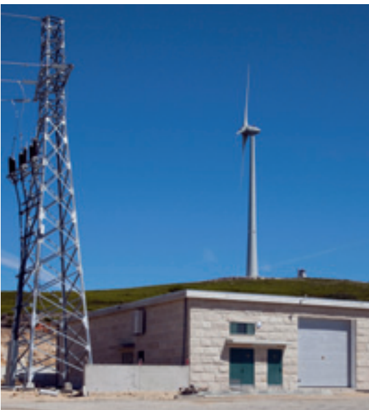
Подключение к сети экологически чистой энергии ветра при помощи компактного КРУЭ типа 8DN8, размещенного в закрытом помещении
