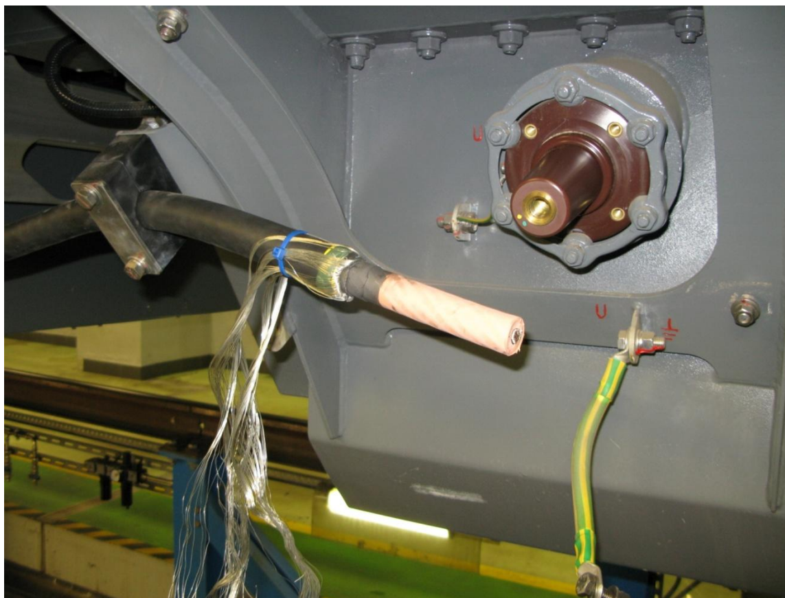
Этап разделки кабеля
