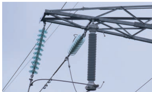
ОКФП Концевая муфта, подвеска
